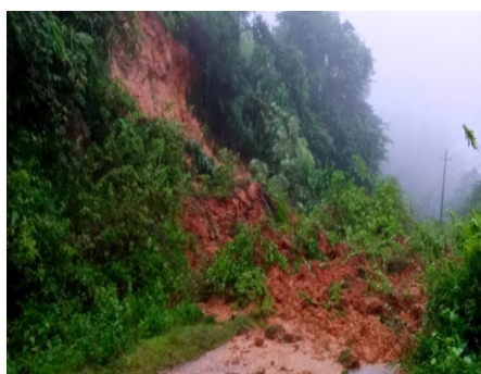
Hình 7. Tuyến đường vào xã Nậm Giải, huyện Quế Phong bị chia cắt vào tháng 9/2023
